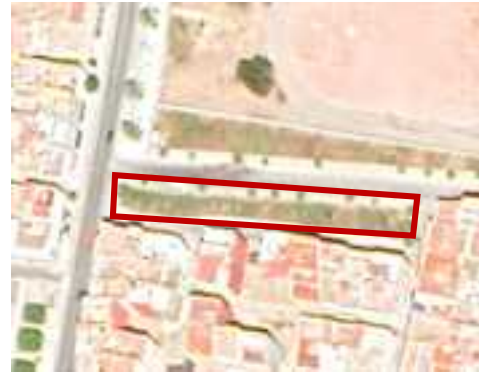
Vue aérienne sur l'espace vert
